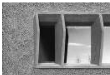
Prefabricated elements, Collège de la Carrière, Crissier
